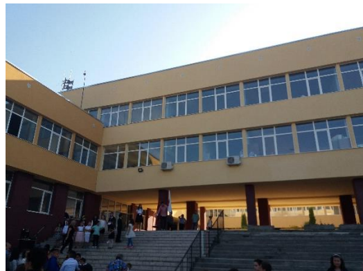
86 ОУ „Св.Климент Охридски“ след саниране на сградата
